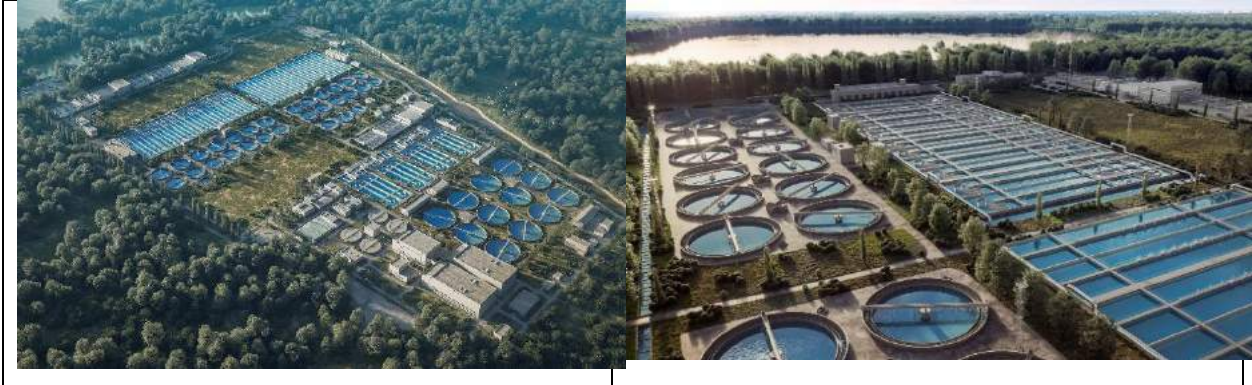
Рис. 3.17. Бортницька станція аерації
