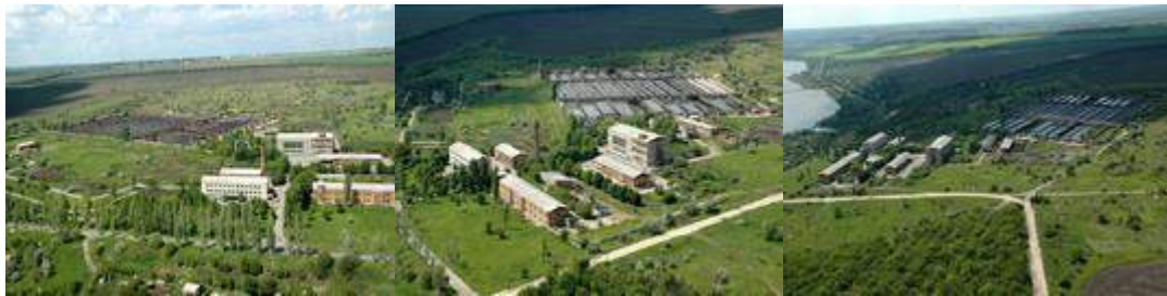
Рис. 3.18. Центральна станція аерації м. Дніпро
