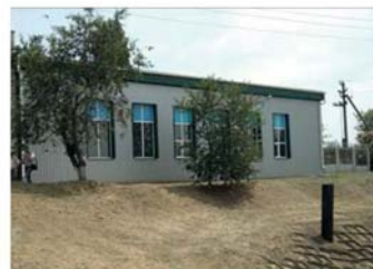
Поточний ремонт будівлі ДНС Південна
