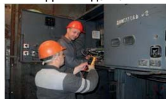
Наладка обладнання ПНС-1 Явківської ЗС
