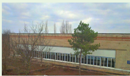
Поточний ремонт будівлі ГНС Спаської ЗС
